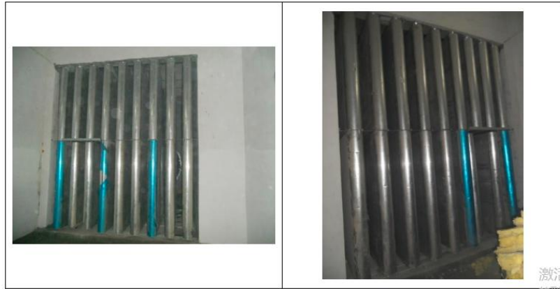
图 2-3-1 风机片式消声器
